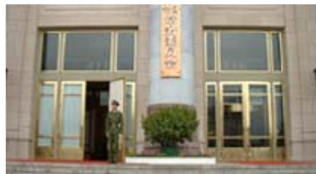
The Great Hall of People, Beijing, China Karuselové dveře na vstupu
