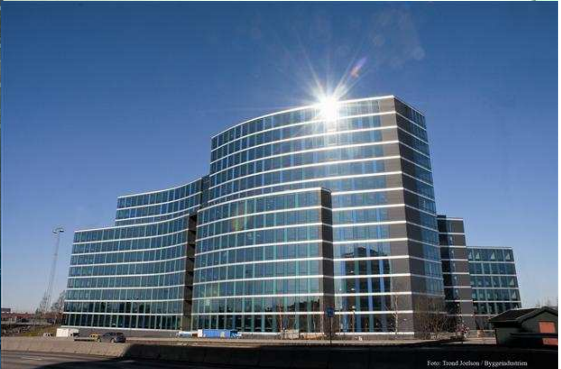
Foto: Trond Joelson / Byggeindustrien
