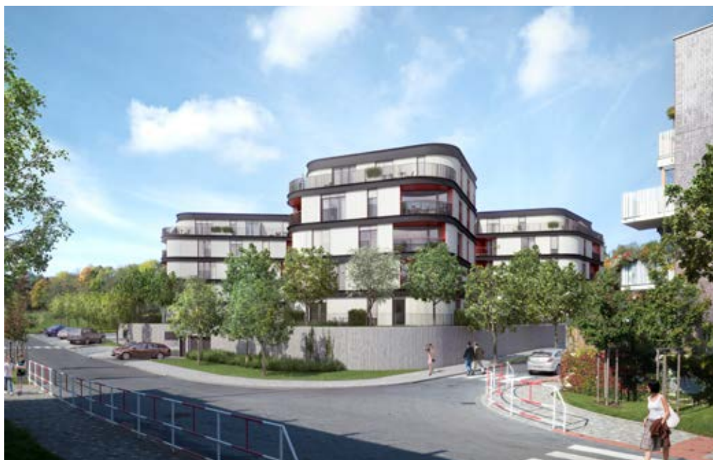
Viladomy Na Vackově developer Metrostav Development, a. s.
