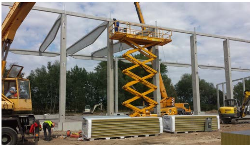
Skladový areál Démon, Hradec Králové technika RAMIRENT, s. r. o.
